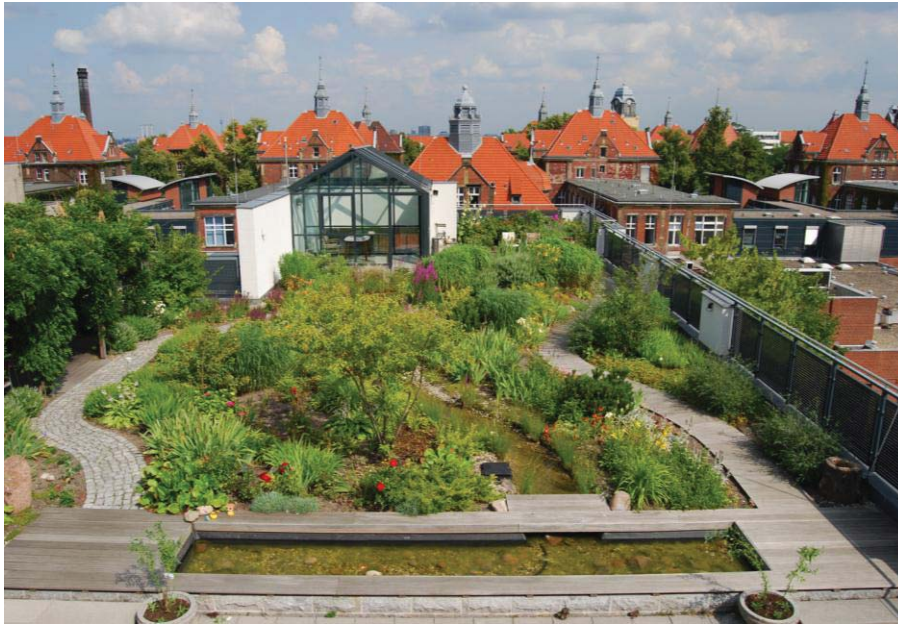
Abbildung 32: Intensiv begrünter Dachgarten, Foto: Fachvereinigung Bauwerksbegrünung e.V.
