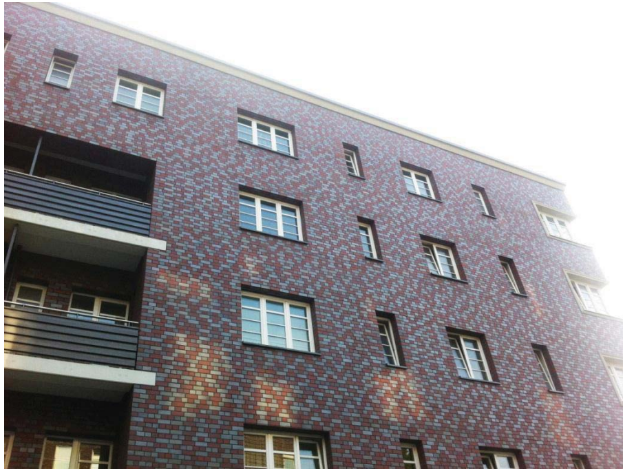
Abbildung 26: Energetische Sanierung eines 1930er Wohnblocks, Foto: Henrik Diemann
