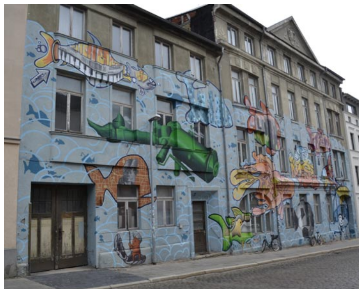
Grundstück Zum Bahnhof 5-7
