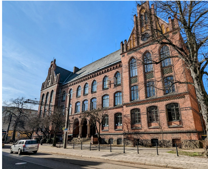
Die umfassenden Sanierungsarbeiten der Friedensschule starten im Sommer.
