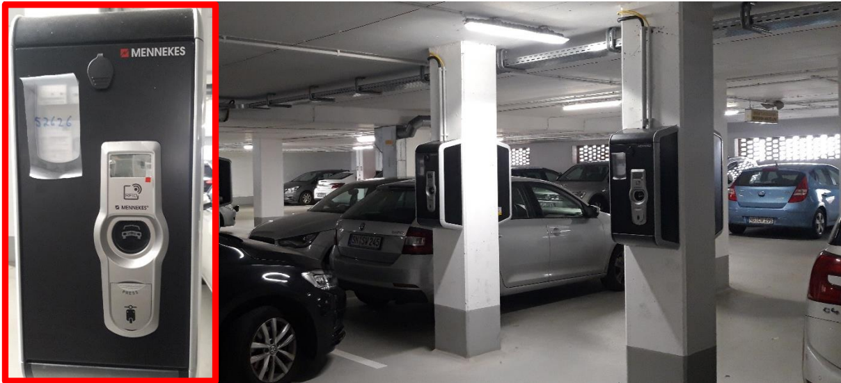
Abbildung 6: Zukünftiges Ladekonzept mit 22 kW Wallboxen (rechts) und Mennekes Wallbox (links, rot umrandet)
