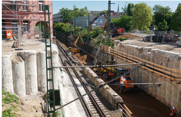
Um den Medienkanal fertigzustellen, ist eine erneute Sperrung der Brücke Wallstraße 2024 für einige Zeit notwendig.
