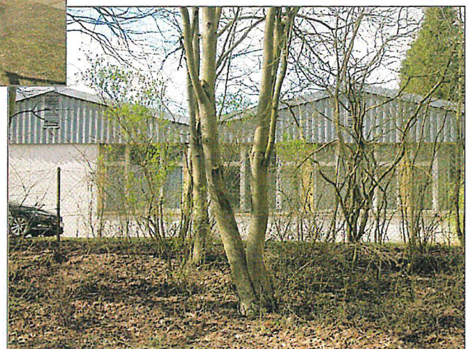
Blick in Richtung Westen Gebäudeteil A
