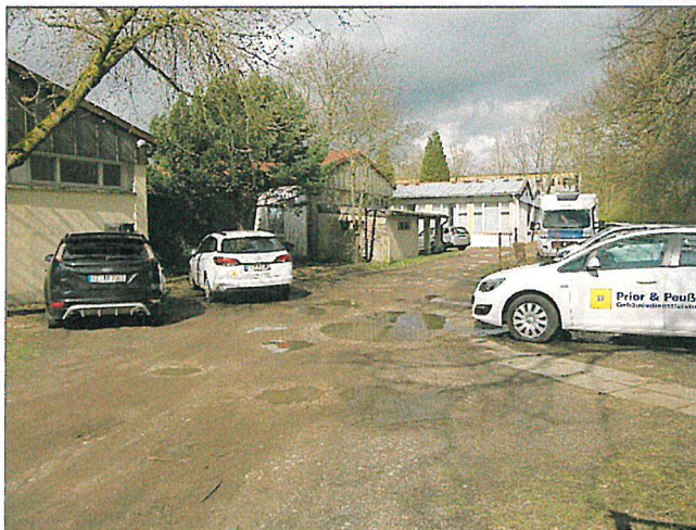
Blick in Richtung Norden Gebäudeteil C
